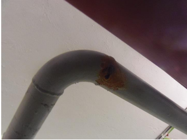
Фото. Следы коррозии.
